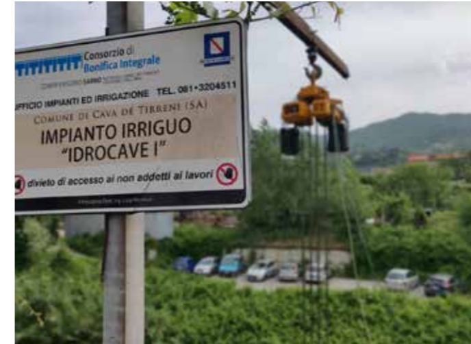
Manutenzione impianto idrocave 1
