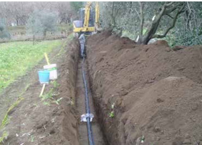
Realizzazione nuova linea irrigua
