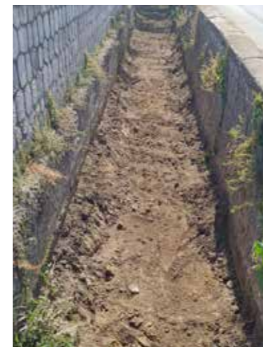
Canale Pietra Perciata – Comune di Castel San Giorgio Sfalcio manuale della vegetazione infestante presente sul fondo alveo. Lavori di rimozione, trasporto in discarica autorizzata e smaltimento dei fanghi di dragaggio
