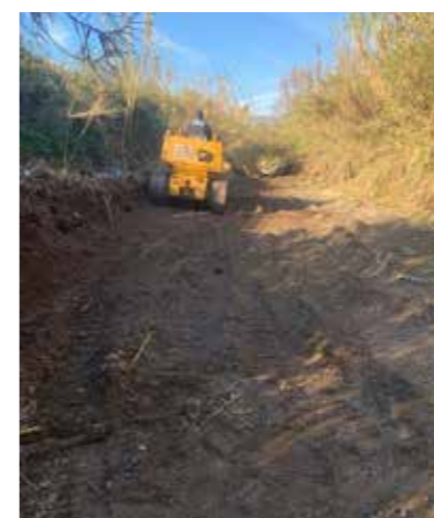
Torrente Calvagnola – Comune di Fisciano Sfalcio meccanico e manuale della vegetazione infestante presente sul fondo alveo e sulle sponde Ripristino sezione idraulica con mezzi meccanici
