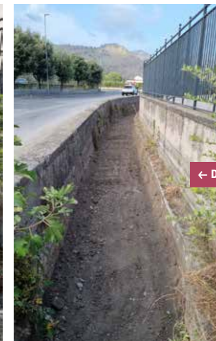
Canale Pietra Perciata – Comune di Castel San Giorgio Sfalcio manuale della vegetazione infestante presente sul fondo alveo. Lavori di rimozione, trasporto in discarica autorizzata e smaltimento dei fanghi di dragaggio
