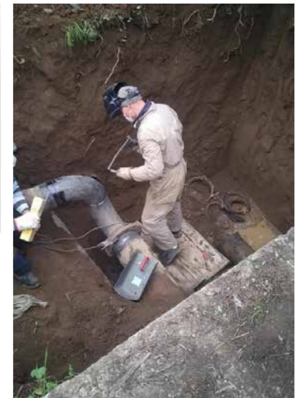
Sostituzione condotta in acciaio con saldatura ad arco elettrico
