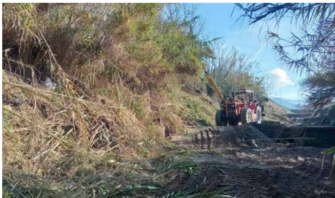
Torrente Calvagnola – Comune di Fisciano Sfalcio meccanico e manuale della vegetazione infestante presente sul fondo alveo e sulle sponde Ripristino sezione idraulica con mezzi meccanici
