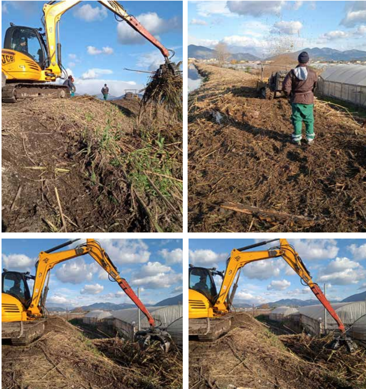
Alveo Comune Nocerino – Comune di San Marzano sul Sarno Sfalcio meccanico e manuale della vegetazione infestante presente sulle sponde (tratto finale) Raccolta e smaltimento dei rifiuti abbandonati nelle aree di pertinenza
