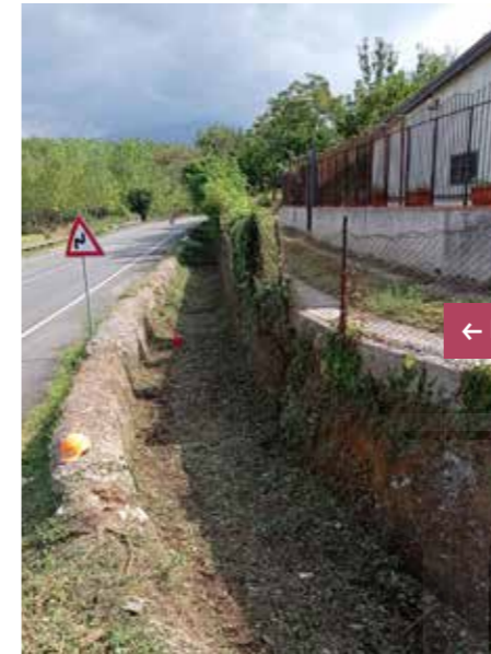
Canale Coscia – Comune di Mercato San Severino Sfalcio manuale della vegetazione infestante presente sul fondo alveo Ripristino sezione idraulica con mezzi meccanici
