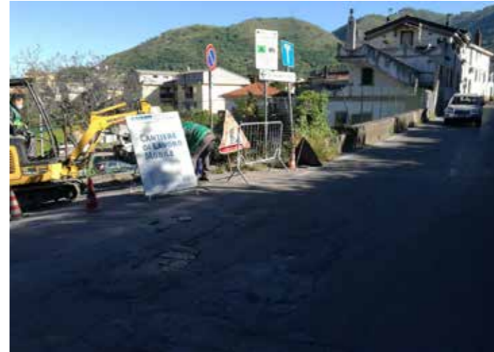
Manutenzione condotta tombata sotto sede stradale
