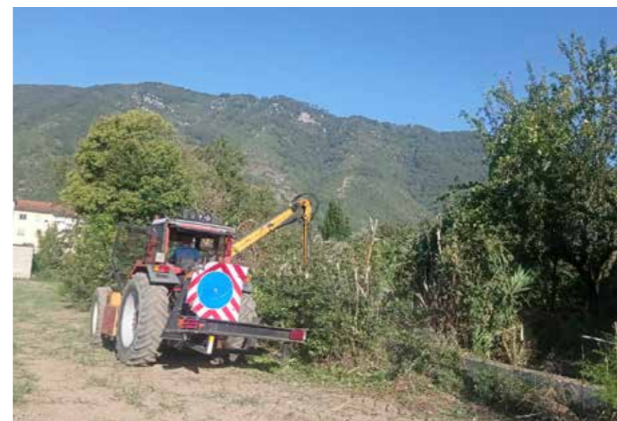
Canale Vietri – Comune di Montoro Sfalcio meccanico e manuale della vegetazione infestante presente sul fondo alveo e sulle sponde
