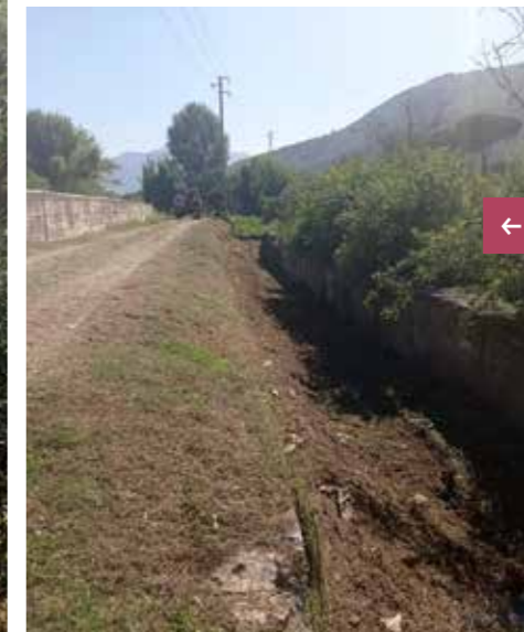
Collettore Roccapiemonte – Comune di Roccapiemonte Sfalcio meccanico e manuale della vegetazione infestante presente sul fondo alveo e sulle sponde
