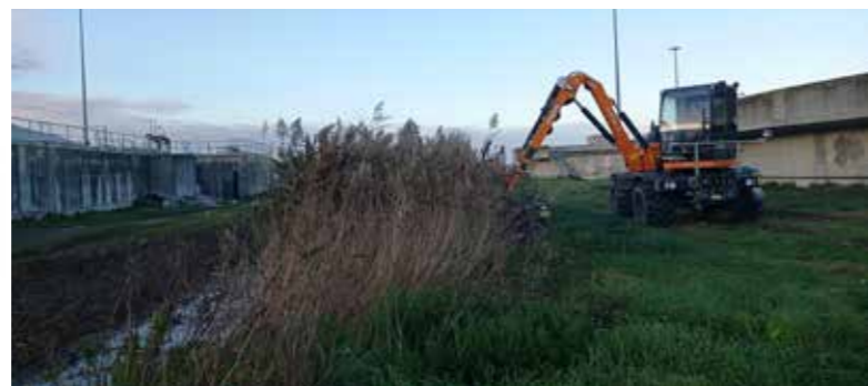
Canale Fosso del Mulino – Comuni di Sant’Antonio Abate e Scafati Sfalcio meccanico della vegetazione infestante presente sul fondo alveo e sulle sponde. Raccolta e smaltimento rifiuti presso ditta convenzionata
