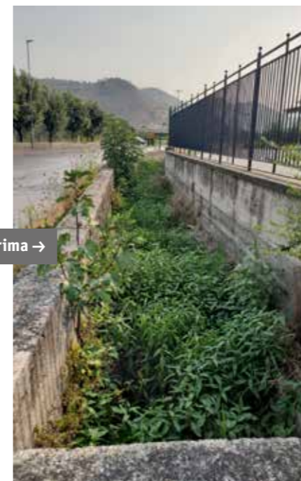
Canale Pietra Perciata – Comune di Castel San Giorgio Sfalcio manuale della vegetazione infestante presente sul fondo alveo. Lavori di rimozione, trasporto in discarica autorizzata e smaltimento dei fanghi di dragaggio
