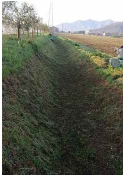
Canale Masseria – Comune di Montoro Sfalcio manuale della vegetazione infestante presente sul fondo alveo e sulle sponde Ripristino sezione idraulica con mezzi meccanici
