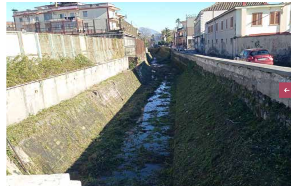
Canale Bottaro – Comune di Scafati (tratto iniziale Via Zara e Via Del Polverificio) Sfalcio manuale della vegetazione infestante presente sul fondo alveo Raccolta rifiuti e trasporto materiale residuo in strutture autorizzate
