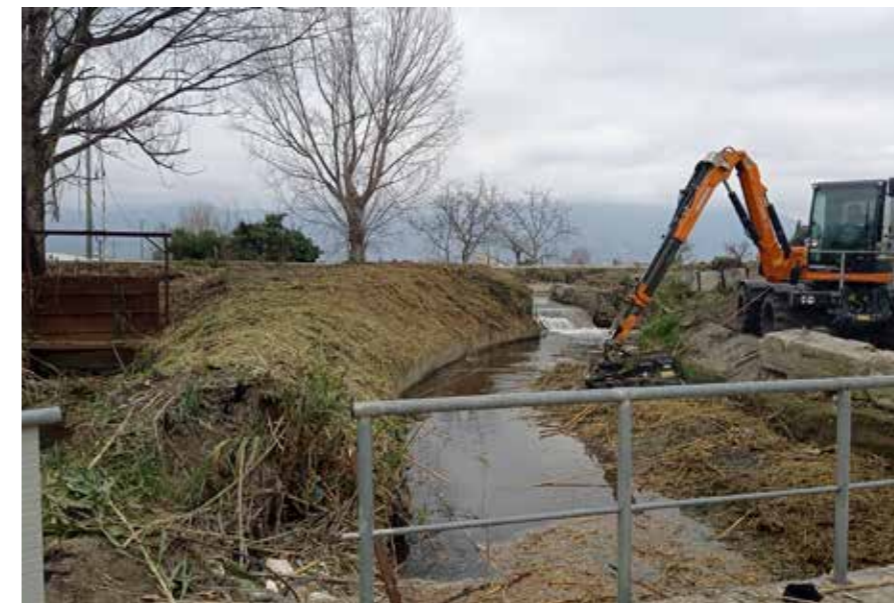
Alveo Comune Nocerino – Comune di San Marzano sul Sarno Sfalcio meccanico e manuale della vegetazione infestante presente sulle sponde (tratto finale) Raccolta e smaltimento dei rifiuti abbandonati nelle aree di pertinenza
