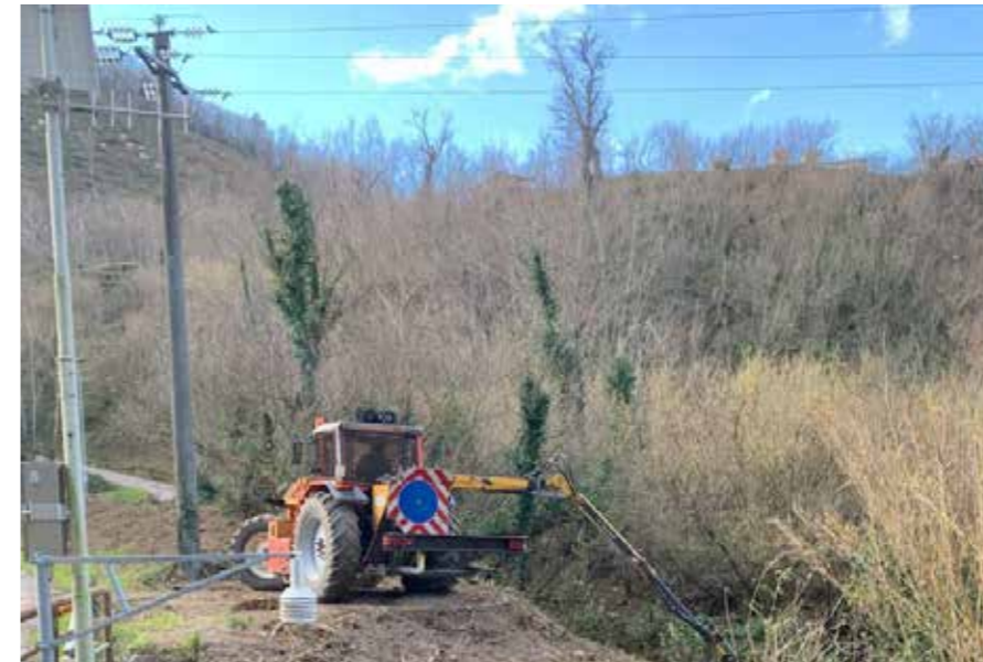
Torrente San Rocco – Comune di Fisciano Sfalcio meccanico della vegetazione infestante presente sul fondo alveo e sulle sponde
