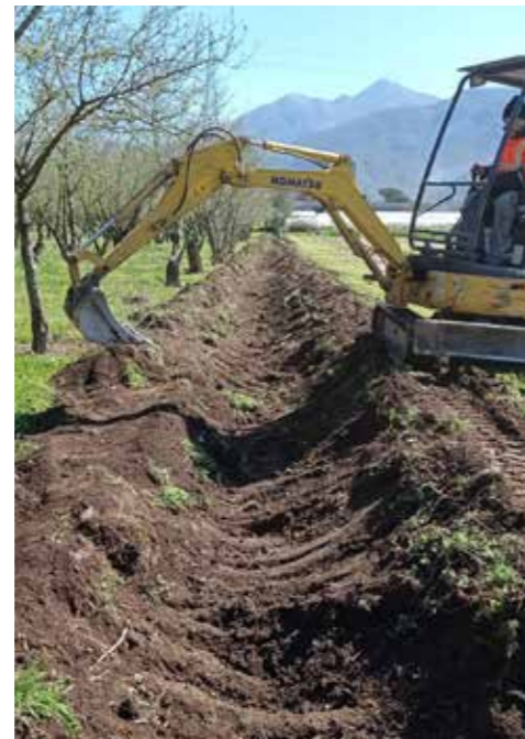
Canale Masseria – Comune di Montoro Sfalcio manuale della vegetazione infestante presente sul fondo alveo e sulle sponde Ripristino sezione idraulica con mezzi meccanici
