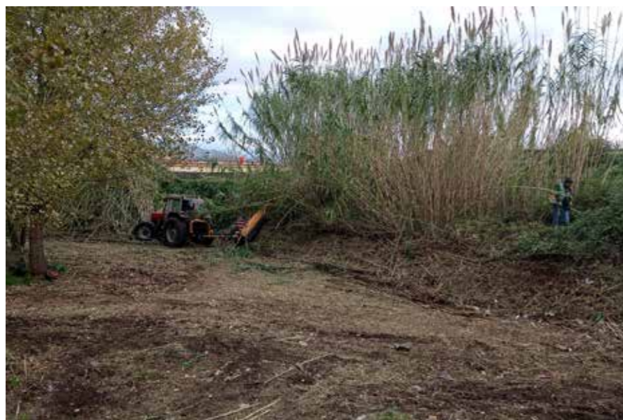
Vasca Corbara – Comuni di Corbara e Sant'Egidio del Monte Albino Sfalcio meccanico della vegetazione infestante presente sul fondo alveo e sugli argini
