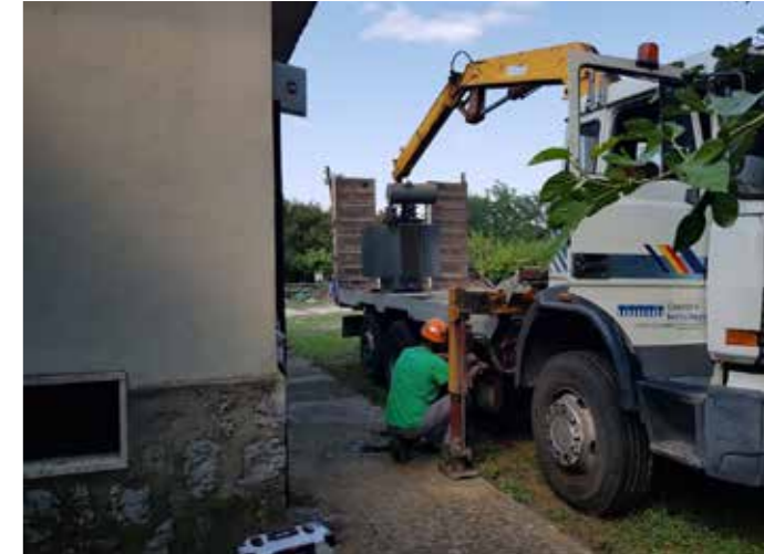
Sostituzione trasformatore MT/BT
