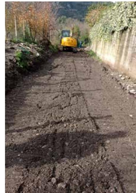
Vallone Sant'Andrea – Comune di Montoro Sfalcio meccanico della vegetazione infestante presente sul fondo alveo e sulle sponde Ripristino sezione idraulica con mezzi meccanici
