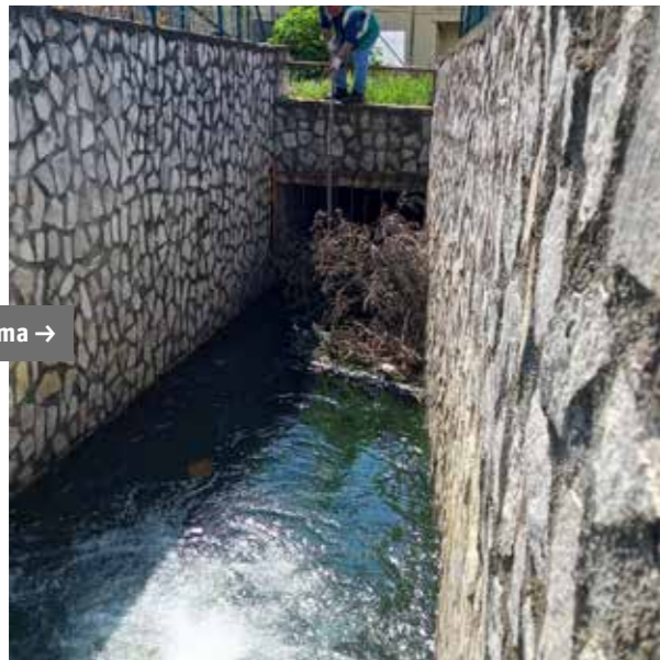
Griglia Rio Cerola – Comune di Sarno Interventi periodici di disostruzione a tutela della pubblica incolumità
