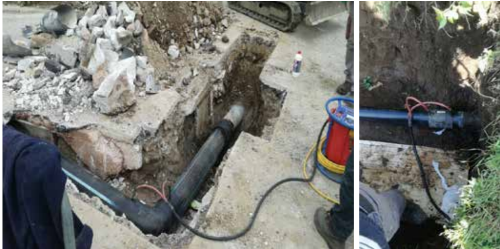
Installazione condotta irrigua in PeAD con saldatura a termofusione
