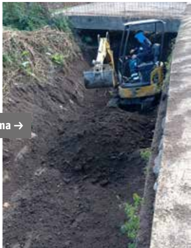
Vallone San Cipriano – Comune di Montoro Ripristino sezione idraulica con mezzi meccanici
