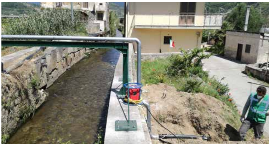
Realizzazione di ponte tubo sul torrente Casarzano
