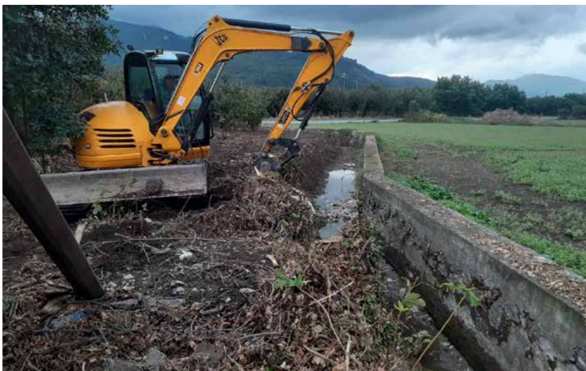
Canale Vietri – Comune di Montoro Ripristino sezione idraulica con mezzi meccanici
