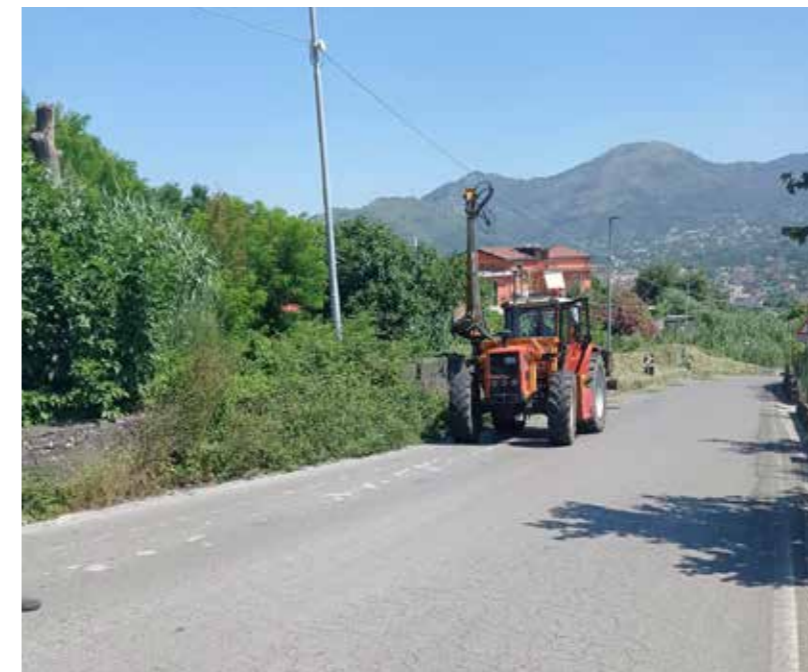
Vallone Petrarò S. Stefano – Comune di Cava de' Tirreni Sfalcio meccanico e manuale della vegetazione infestante presente sul fondo alveo e sulle sponde. Ripristino sezione idraulica con mezzi meccanici
