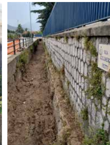
Canale Pietra Perciata – Comune di Castel San Giorgio Sfalcio manuale della vegetazione infestante presente sul fondo alveo. Lavori di rimozione, trasporto in discarica autorizzata e smaltimento dei fanghi di dragaggio
