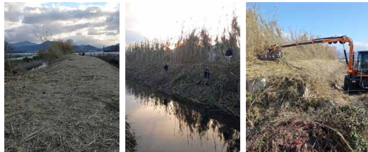
Alveo Comune Nocerino – Comune di San Marzano sul Sarno Sfalcio meccanico e manuale della vegetazione infestante presente sulle sponde (tratto finale) Raccolta e smaltimento dei rifiuti abbandonati nelle aree di pertinenza
