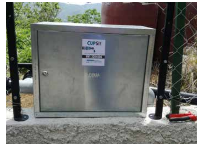
Posizionamento contaltri per nuovo allaccio alla rete irrigua
