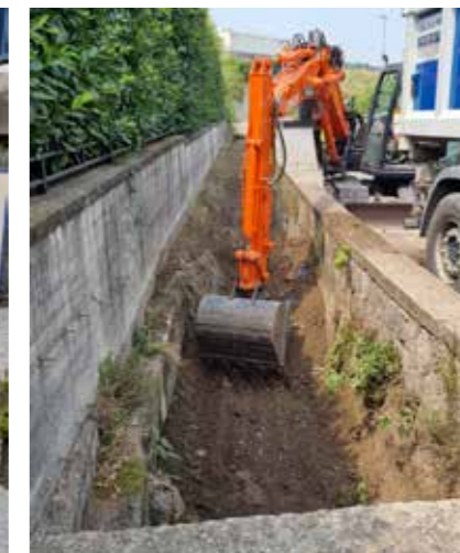
Canale Pietra Perciata – Comune di Castel San Giorgio Sfalcio manuale della vegetazione infestante presente sul fondo alveo. Lavori di rimozione, trasporto in discarica autorizzata e smaltimento dei fanghi di dragaggio
