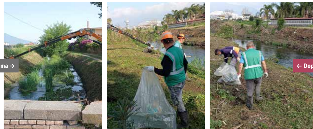
Canale Marna – Comuni di Sant’Antonio Abate, Scafati e Pompei (1° intervento) Sfalcio meccanico della vegetazione infestante presente sul fondo alveo e sulle sponde Rimozione rifiuti indifferenziati
