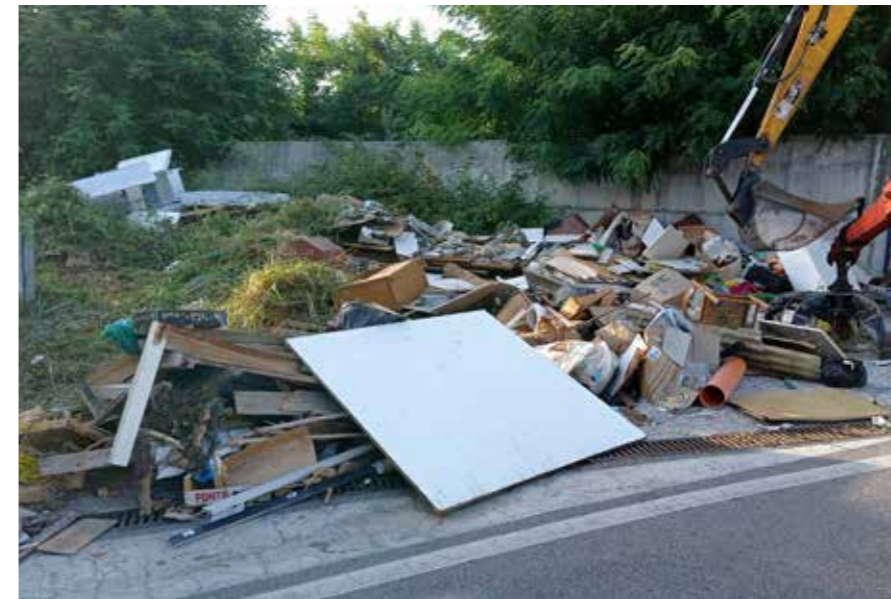
Canale Bottaro – Comune di Pompei (Via Astolelle) Lavori urgenti per la rimozione dei rifiuti abbandonati e trasporto presso impianto autorizzato
