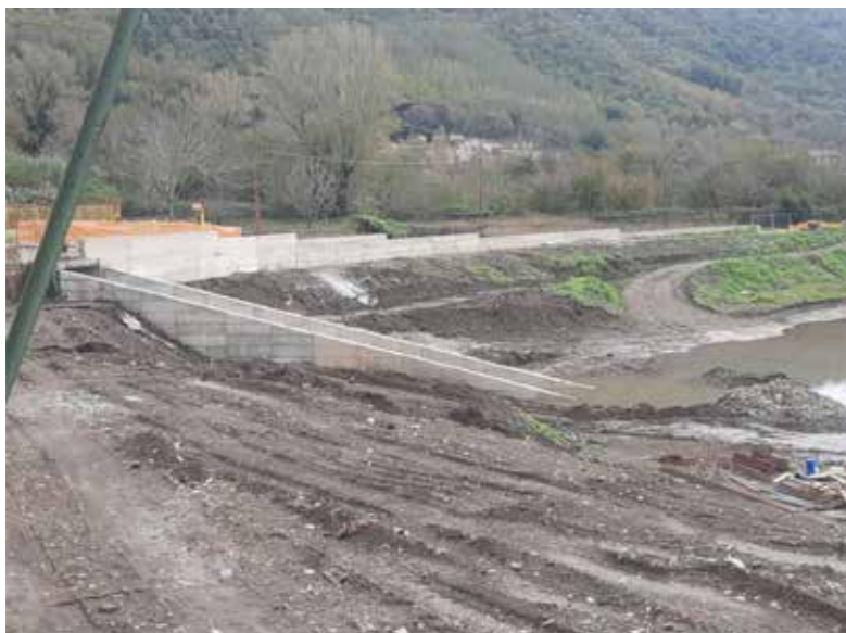
Opera di sbocco immissario secondario e muri perimetrali lato Est
