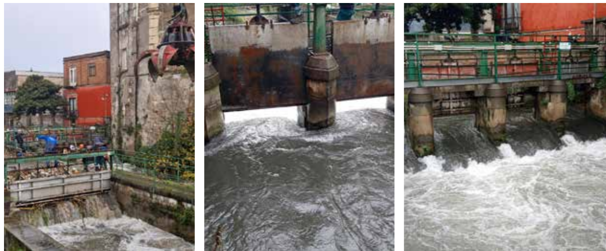
Presidio idraulico complesso delle paratoie sul fiume Sarno – Comune di Scafati Interventi periodici di disostruzione a tutela della pubblica incolumità
