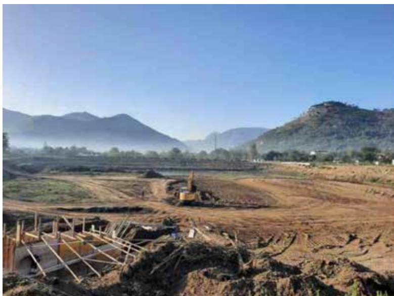
Movimenti terra per ampliamento e sistemazione vasca
