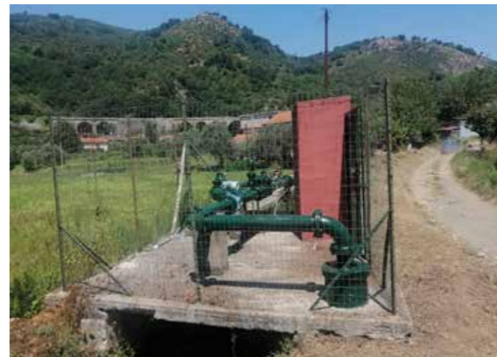
Manutenzione componenti idraulici Pozzo Labso
