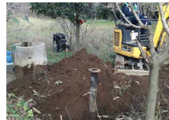
Installazione nuovo idrante
