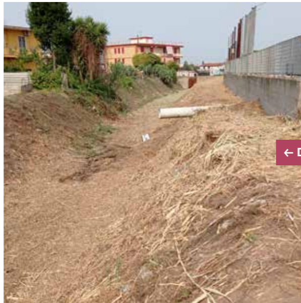
Canale Bottaro – Comuni di C/mare di Stabia e Pompei (tratto nei pressi del CC Le Porte di Pompei) Sfalcio meccanico e manuale della vegetazione infestante presente sul fondo alveo e sulle sponde
