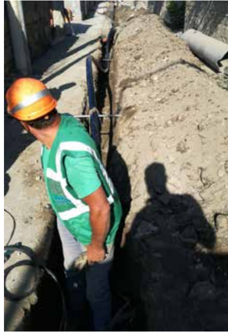
Realizzazione nuova linea irrigua
